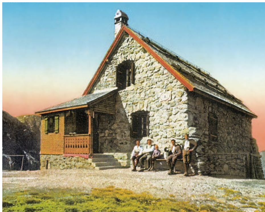
1915 wurde die SAC-Hütte auf 2229 m erbaut und 1932 auf 100 Schlafplätze erweitert.
